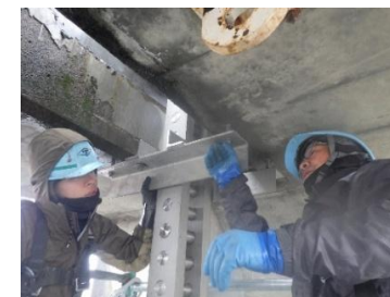
振れ止め 取付け作業
