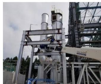
入口フード架台 ボルト入れ
