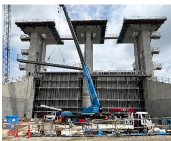
点検橋吊り込み
