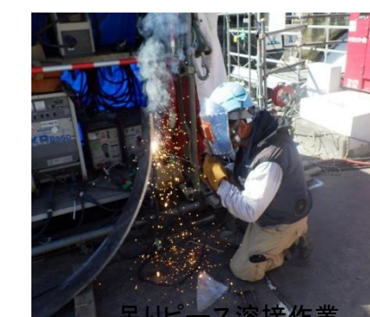
吊りピン溶接作業
