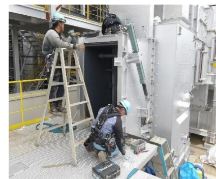
ドラム扉開閉部分 据付作業
