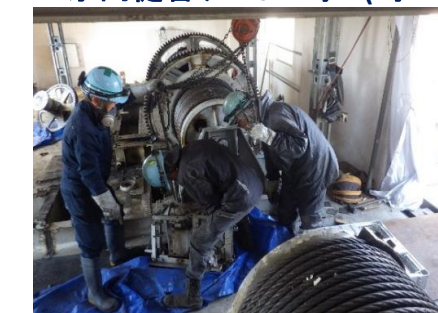
主ゲート 開閉機撤去
