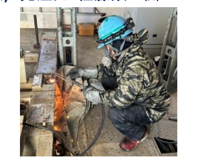
主ゲート 開閉機解体
