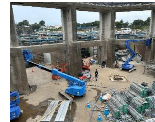
差筋削孔作業
