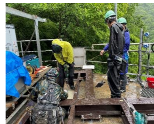
コモンベースアンカー削孔
