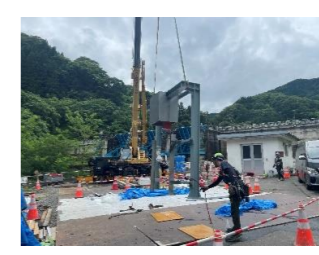
ガイドレール吊り込み
