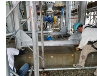
アンカー締め込み
