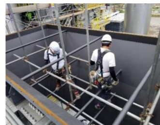
内部溶接用足場組立
