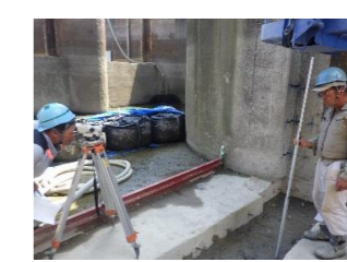
下部アングル設置位置確認
