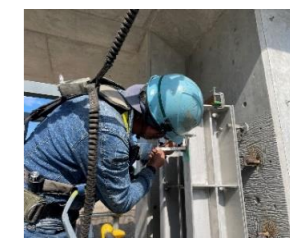
サイドローラー 下げ振り セット中
