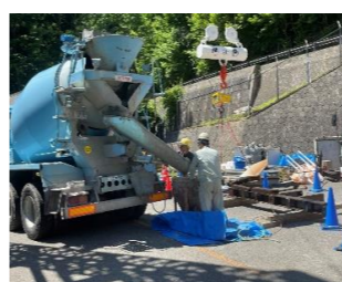
コンクリ荷上げ
