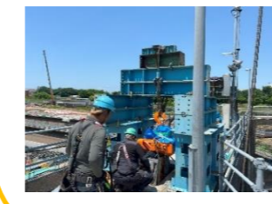
扉体吊り出し準備
