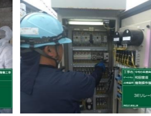
機側操作盤 動作確認
