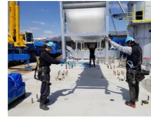
落じんコンベア据付
