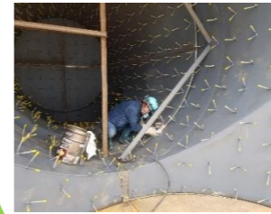
高温煙道 内部溶接
