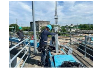
開閉装置解体
