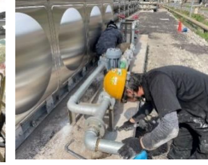
サポートアンカー取付中
