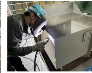
サポート溶接中
