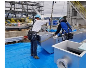
吐出ダクト 地組
