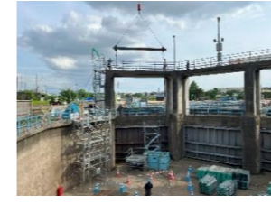
扉体吊り出し準備
