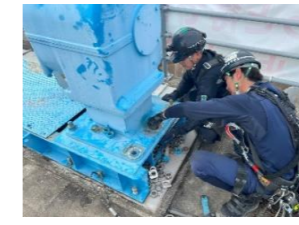
開閉装置解体
