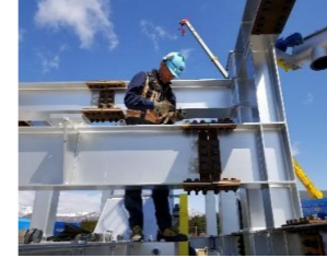
燃焼炉架台 ボルト入れ
