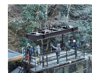
開閉機架台吊り込み
