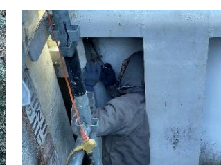
アンカーボルト設置
