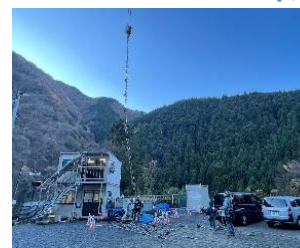
吊上げ装置ワイヤー設置
