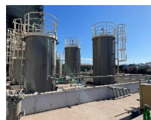
油配管敷設中
