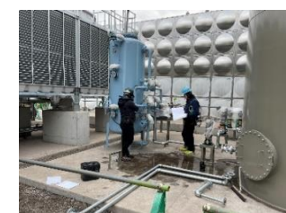
砂ろ過処理水接続部確認中
