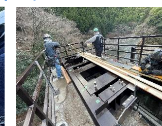
開閉機架台型枠加工取付
