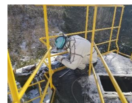
固化灰貯留槽 天井板撤去
