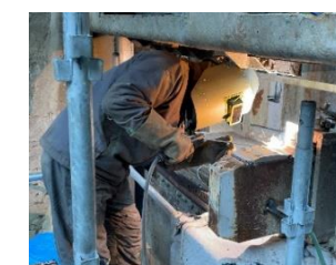
可動ストッパー コッター溶接
