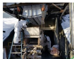
主灰コンベア解体
