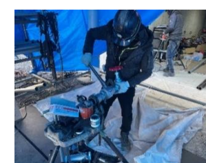
冷却水配管製作中
