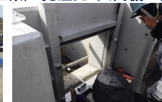
据付位置確認
