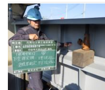
下塗完了 塗膜厚測定
