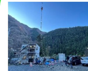
吊上げ装置ワイヤー設置
