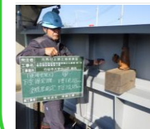
下塗完了 塗膜厚測定
