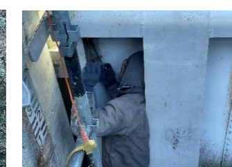
アンカーボルト設置
