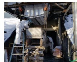
主灰コンベア解体
