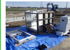
荷下ろし完了
