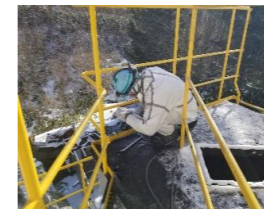
固化灰貯留槽 天井板撤去
