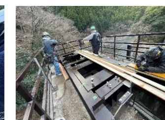
開閉機架台型枠加工取付
