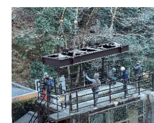
開閉機架台吊り込み
