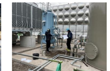
砂ろ過処理水接続部確認中
