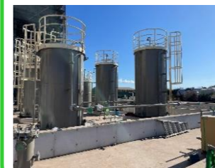
油配管敷設中
