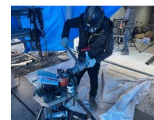
冷却水配管製作中
