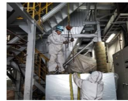
コンプレッサー搬入
