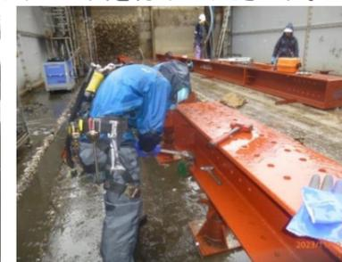
1号ゲート下流 架台組立作業
