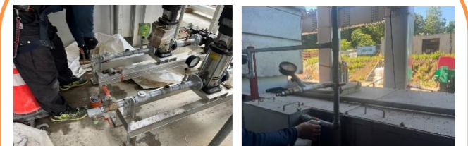
減温水 配管設置
