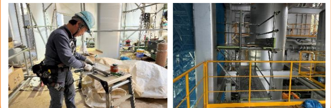
エアライン 配管加工
