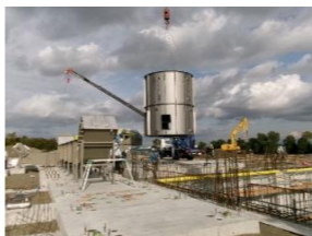
再燃燃焼室据付
