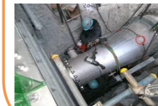
放流管取付作業
