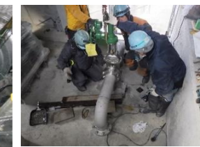
充水管取付作業
