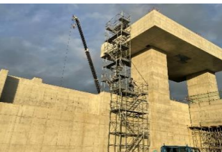
左岸昇降用足場組立
