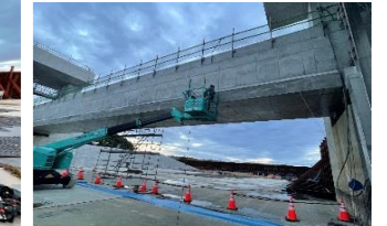
差し筋アンカー削孔
