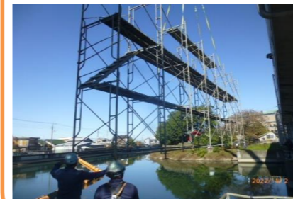
足場吊り込み作業
