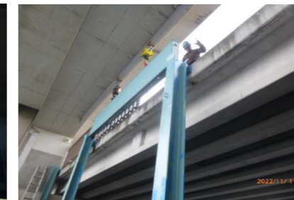
角落し設置作業
