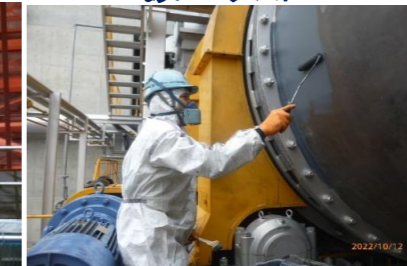
キルン炉塗装作業
