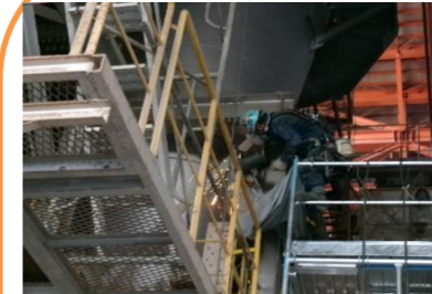
ダクトブラケット取付
