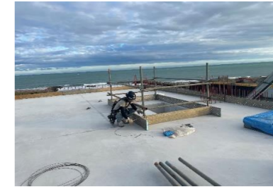
左岸開閉機ピア開口部養生
