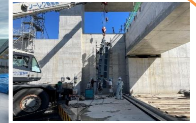
左岸側部戸当り据付用 足場組立状況
