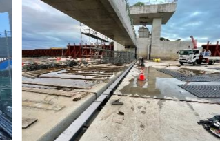
下部戸当り溶接固定状況
