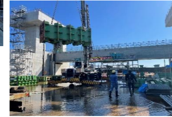
山留材荷下ろし
