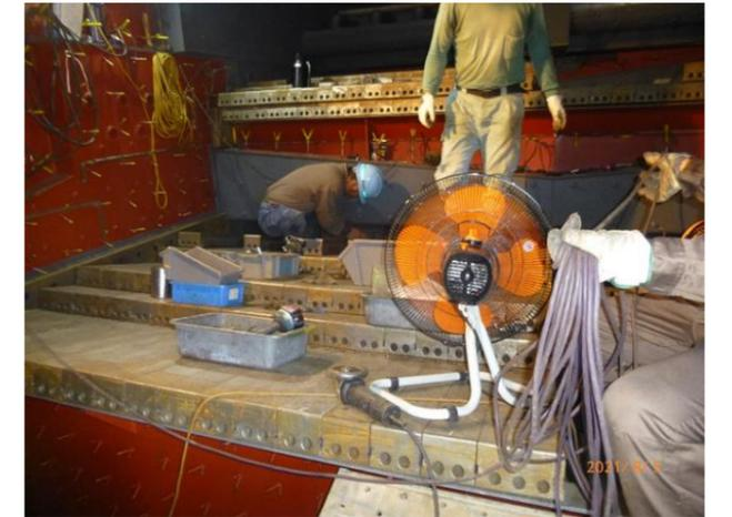
焼却炉内鑄物調整状況
